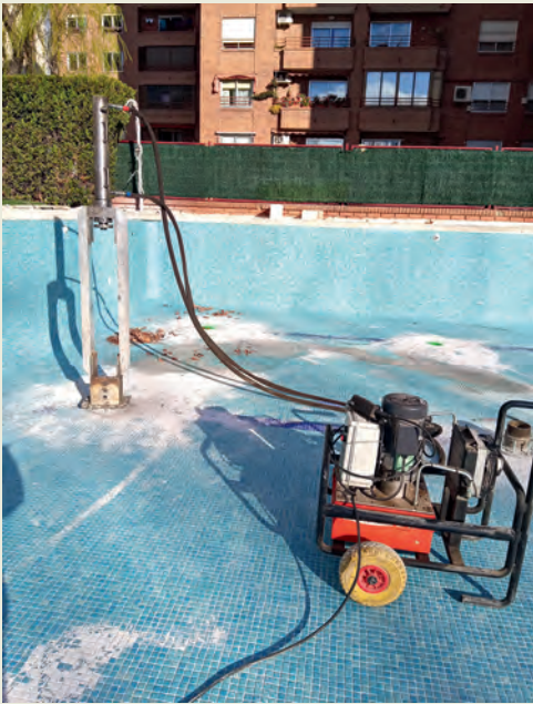
Arriba, de izquierda a derecha, centralita electrohidráulica; piscina micropilotada antes del corte de sobrante, y placa antipunzonamiento. A la derecha, emparrillado y camisas metálicas pasatubos.
