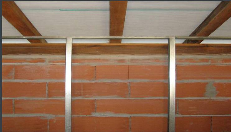
❶ Se fija la estructura metálica sobre la pared. Si el aislante se va a colocar detrás de los montantes prever un espacio entre la pared y la estructura igual al espesor del aislante.
