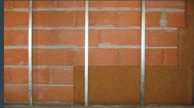
❷ Se colocan los paneles detrás o en el interior de los montantes según el espesor del aislante y de los montantes
