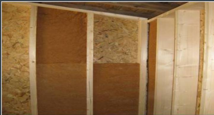
❷ Después de la colocación del aislante y antes de la colocación del acabado se grapa sobre los montantes una barrera o freno vapor.
