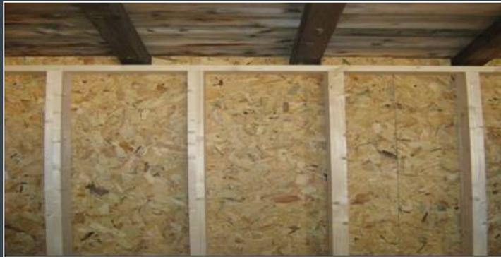
❶ La estructura esta preparada para la colocación del aislante. La distancia entre eje de los montantes es de 40 cm.
