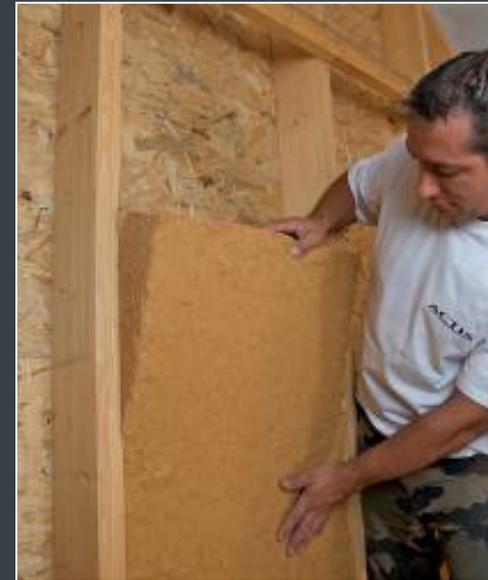
❸ Los paneles tienen 375 cm de ancho. Se encajan entre los montantes
