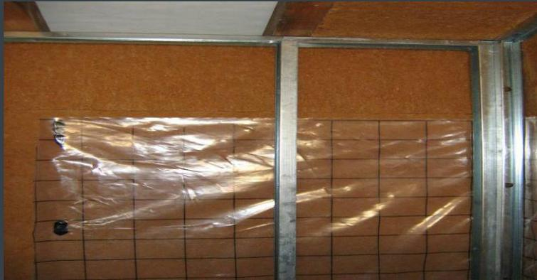
3 Se coloca una barrera de vapor insertándola entre la estructura y el aislante. Se cortan los paneles para ajustar la unión pared-techo
