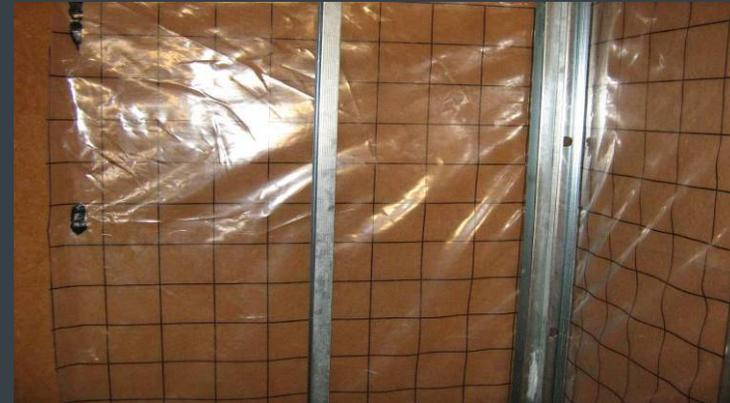
4 La barrera de vapor se pega al aislante mediante toques de mástic-cola
