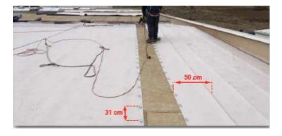
Hay que tener en cuenta y por eso el cálculo de las fijaciones da este resultado que en las zonas perimetrales y en especial las esquinas es donde se produce una mayor succión del viento, por ese motivo se instala la lámina en ancho de 50 cm y los anclajes a muy poca distancia.
