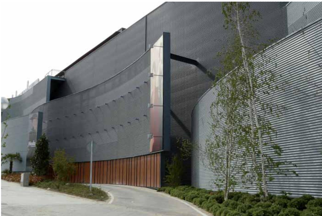
gado con dos colores, uno más oscuro para las zonas traseras, y otro algo más claro, ambos metalizados, y además con chapas totalmente ciegas y chapas microperforadas que permiten ciertos efectos de velos mediante la iluminación nocturna".
