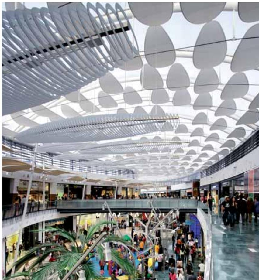
a base de gajos, termosoldando los distintos elementos, de 4 a 4,5 m de anchura por la longitud necesaria en cada punto. La escasez de juntas elimina muchas posibilidades de goteras.
