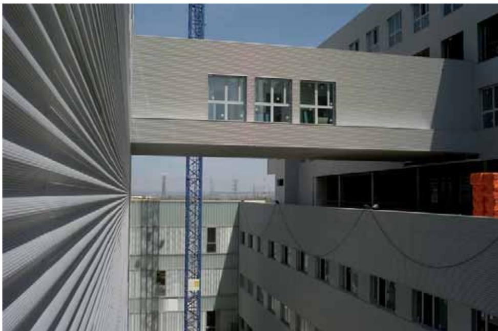
Las fachadas (II-III) se han resuelto mediante la colocación de angulares continuos de 4mm de espesor, anclados con tornillería Hilti HSA M-12 a la parte supe-
