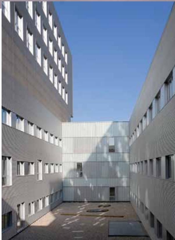
tana o muro cortina, consiguiendo una gran rapidez de ejecución al colocar un elemento de fachada que no necesita terminación, y que además resulta muy positivo por la gran luminosidad que aporta.
