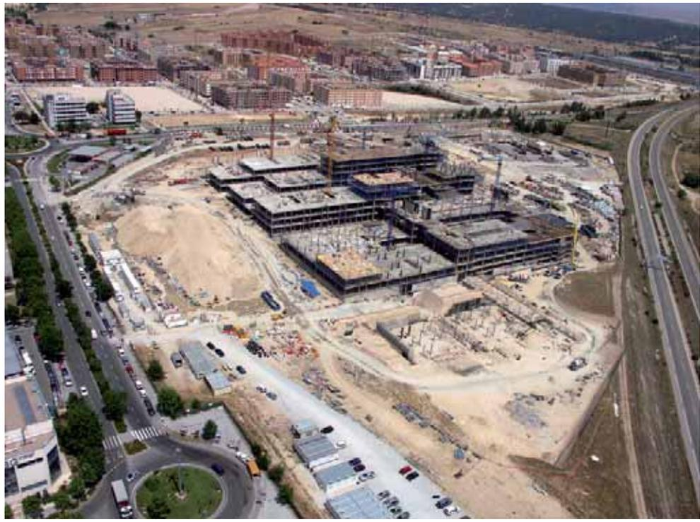
como, por ejemplo, la elección de la estructura postesada, "es un sistema con el que ya habíamos trabajado en anteriores ocasiones; conocíamos su rapidez, evita la duplicidad de pilares, reduce cantos de forjado obteniendo menor cantidad de hormigón por lo que disminuyen las cargas del peso propio en cimentación. El sistema es relativamente novedoso, siendo éste el único de los siete hospitales madrileños en que se ha em-
