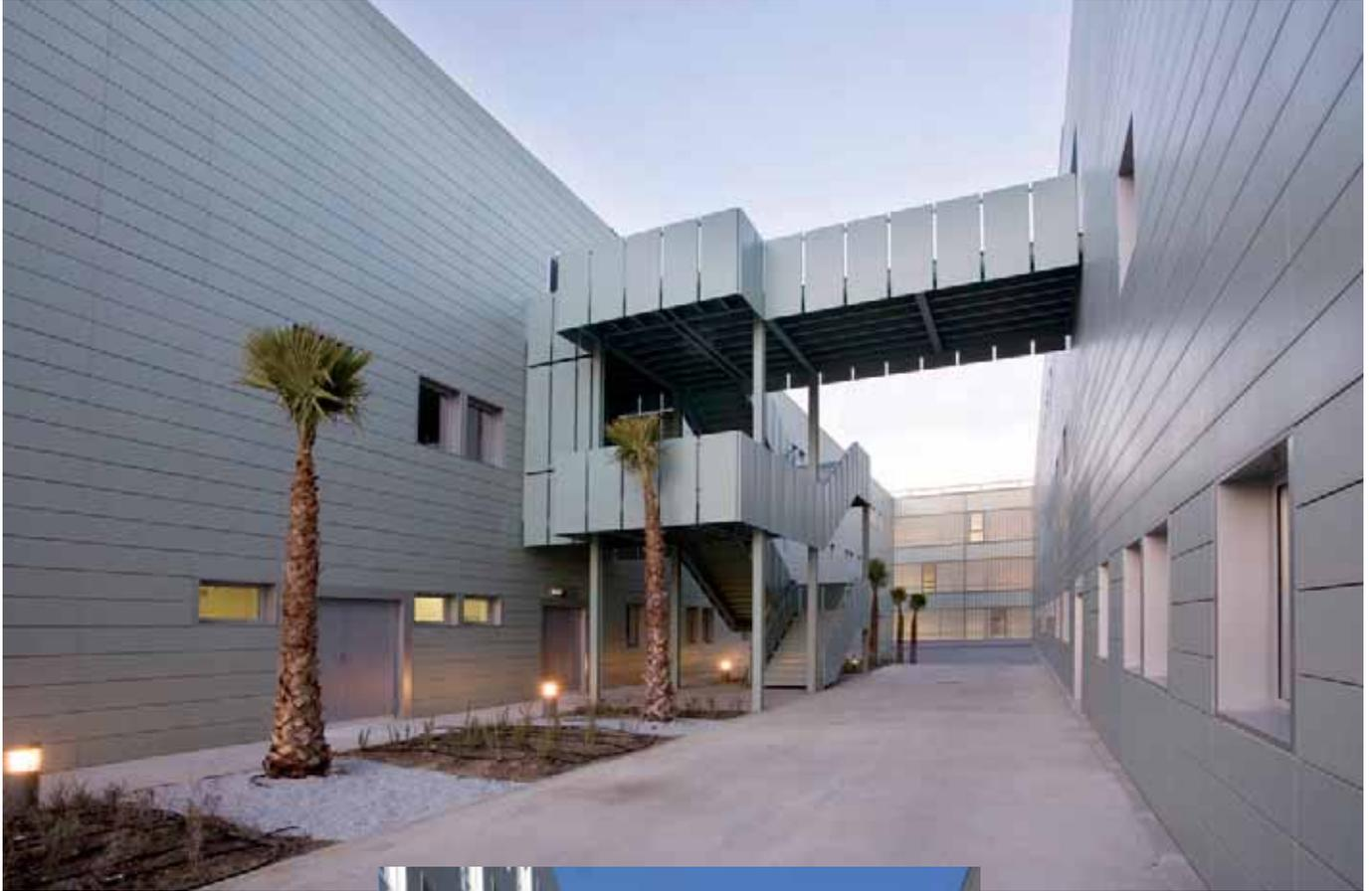
portante del peso de la fachada, siendo la chapa Eurobac-80 de  $9,69 \text{ kg/m}^2$  frente al peso de la fabrica de ladrillo tradicional, sin menoscabo de su resistencia frente a la acción del viento, pues la subestructura metálica, con un montante cada 40 cm, aporta rigidez a la fachada.
