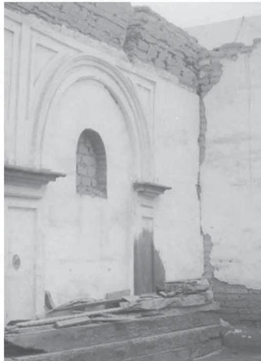
*Fig.2. Fisuras verticales en las esquinas de muros. (Gráfico: J. Kuroiwa, 2002. Foto: P. Hurtado Valdez).*
