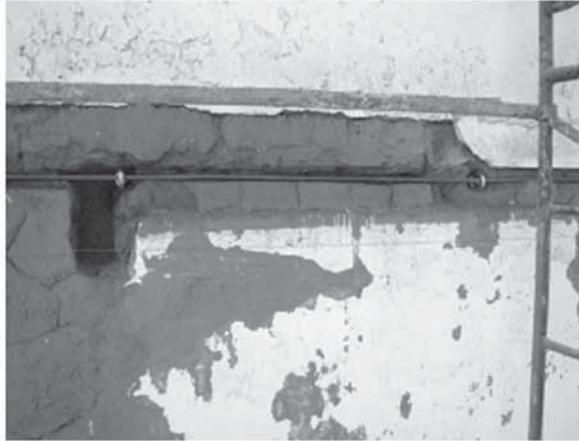
Fig.11: Cables horizontales metálicos aplicados al exterior de los muros. (Gráfico: E. Toelles, 2002. Foto: J. Vargas, 2005).
