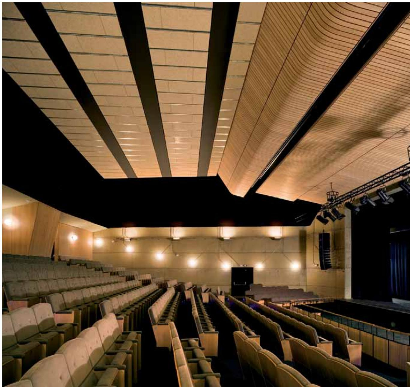
aceite mineral especial que le colorea y da textura, la parte trasera es de cartón yeso perforado con lana de roca, que sirve como absorbente del sonido. Los paneles negros laterales en la unión entre los paramentos y la cubierta son de cartón yeso, pero completamente lisos para mayor reflexión del sonido. En el techo, una primera zona encima de escena está compuesta por reflectores de paneles de madera curvada. La zona más alejada de la misma está integrada por placas de viruta de madera
