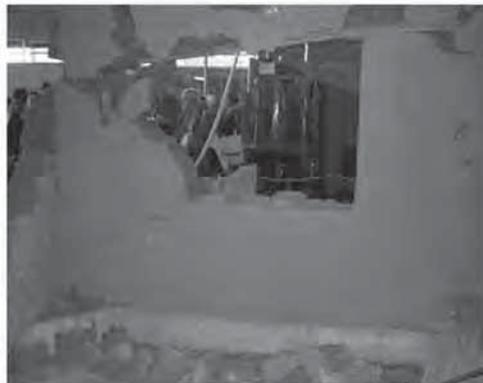
Fig.4. Fisuras diagonales por fuerza cortante. (Grafico: D. Torrealva, s.f. Foto: P. Hurtado Valdez).
