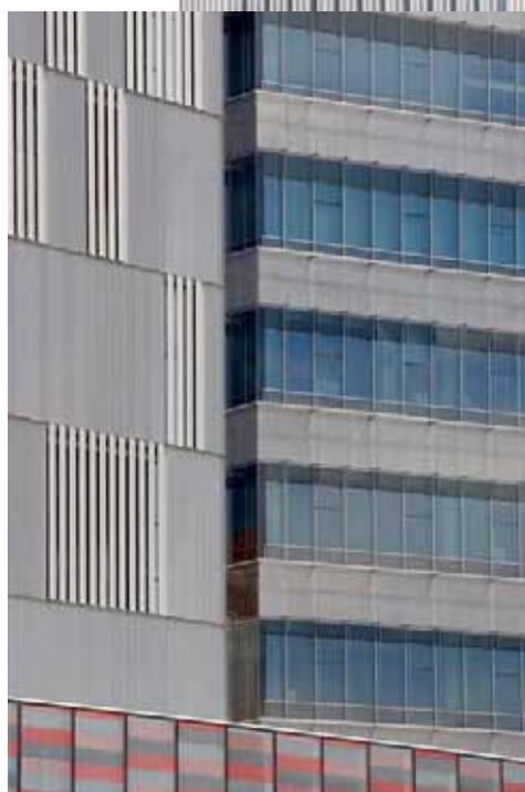
centes se han situado en la pasarela existente entre la celosía de aluminio y el muro cortina de vidrio. De esta manera, se percibe la luz a través de las perforaciones de los perfiles de aluminio extruido y a través de los huecos dispuestos entre algunos perfiles. Con Arkilum se elaboró una secuencia, de siete minutos de duración, que determina la gradación e intensidad de los colores.
