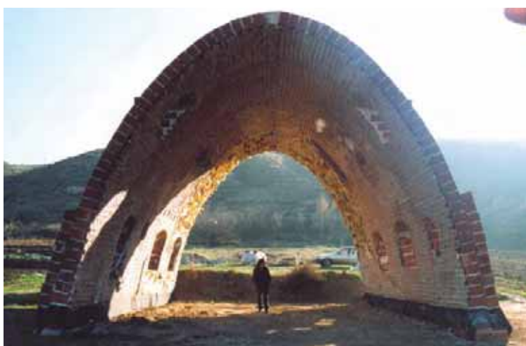
Bóveda en curva catenaria.
