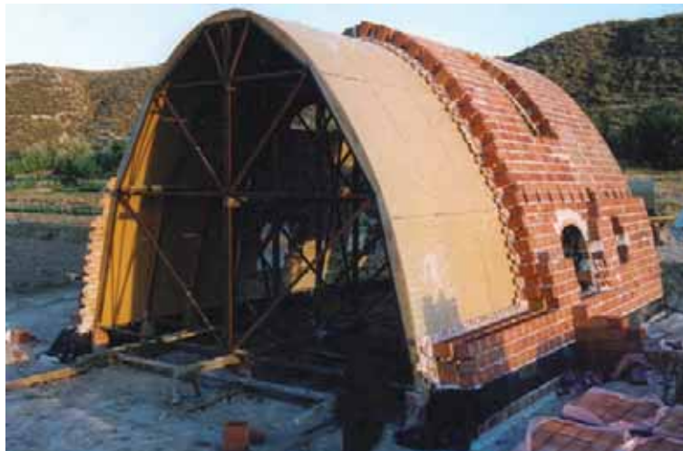
Sobre estas líneas, montaje de la cimbra. A la derecha, bóveda en proceso de construcción.
