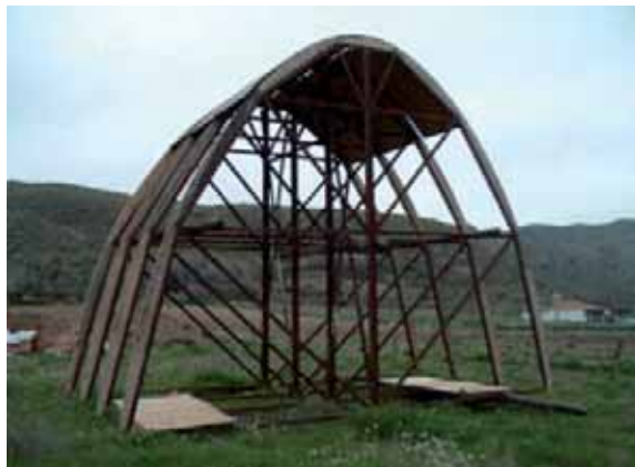
Sobre estas líneas, montaje de la cimbra. A la derecha, bóveda en proceso de construcción.
