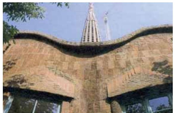
bles tabiques de panderete y gracias a su curvatura, construyó Gaudí las paredes de carga de las Escuelas, de 4 m de altura. La cubierta, construida con bóvedas de rasilla de superficie reglada, son un ejemplo brillante de la innovación del proceso constructivo apoyada en la tradición. Le Corbusier adoptó esta magistral solución de Gaudí para la cubierta de alguna de sus obras más conocidas.
