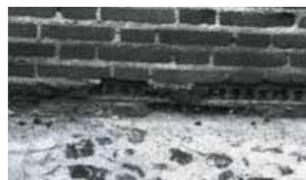
**Foto 6: Fractura por crioclastia en el repi de un muro.**
