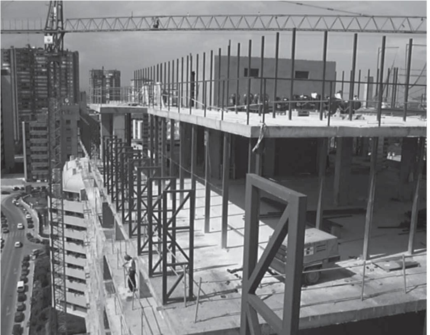
montaje de ferralla de vigas, montaje de viguetas, bovedillas, armaduras de negativos, armaduras de reparto, etc. Sabiendo "qué" se pretende hacer y "cómo" se va a hacer, se podrán analizar los riesgos que, en cada momento de esta secuencia, se van a presentar.
