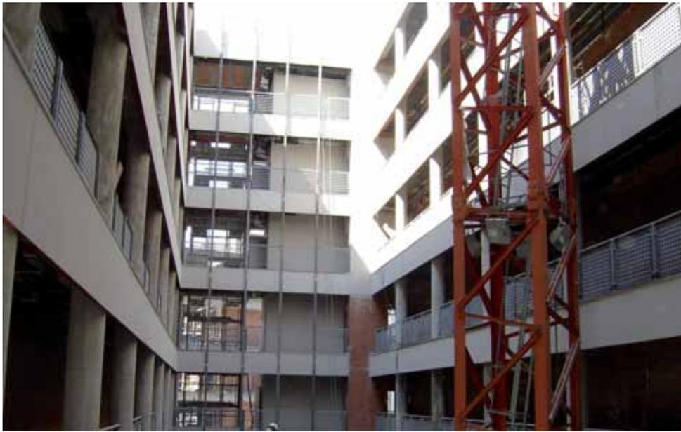
migón. Los paneles prefabricados de hormigón o GRC son el elemento utilizado en el exterior del edificio. El cerramiento se completa con carpintería metálica y vidrio doble, tipo Climalit, con cámara de aire en las fachadas longitudinales de ambos bloques.
