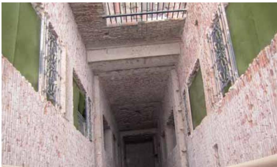
plantas 4ª, 3ª, 2ª, entreplanta y 1ª, hubo que realizar diferentes huecos en el forjado, para ir echando los escombros por una trompa de desescombro, que transcurría entre las diferentes plantas hasta llegar a la planta baja, donde se acumulaba el escombros hasta poder sacarlo a los contenedores.
