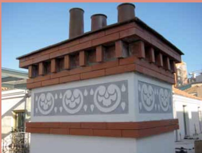
Nueva chimenea con esgrafiado sacado con plantillas.
