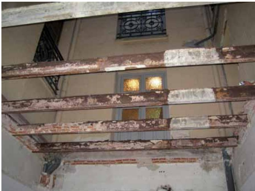
vantado de mamparas y revestimientos de madera, picoteado de paramentos verticales de yeso, enfoscados y alicatados, demolición de pavimentos y material de agarre sobre forjados. Todos estos trabajos se hicieron de forma manual, con pequeños martillos neumáticos, picos y palas.
