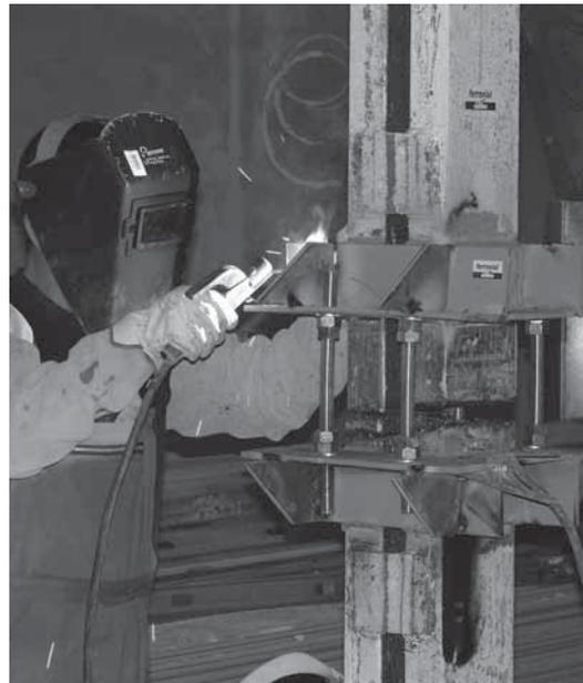
4. Corte del pilar metálico original.
