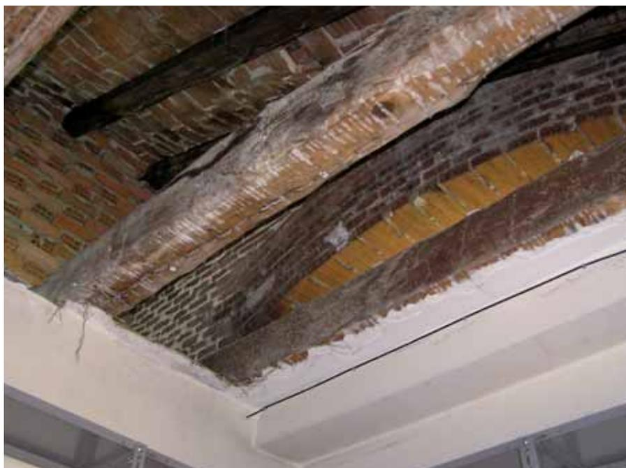
ponerse la estructura de madera de la cubierta a su estado primitivo. De paso, se corrigió puntualmente otra zona, eliminando un encuentro con problemas de evacuación de agua, introduciendo una nueva limahoya. Además de las actuaciones descritas, se extendió sobre la totalidad de los forjados existentes, a la vez
