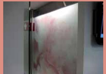
Paneles de vidrio retroiluminado con fotografía de mármol en el butiral del vidrio laminado.
