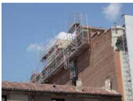
de la acera al montacargas y/o a la planta baja. Su movimiento era muy limitado y lento, para no tener ningún incidente por la acera, siendo el acceso a planta baja hasta un metro aproximadamente, dado que el forjado no admitía sobrecargas; de ahí se trasladaban los materiales, mediante traspalets, por las inmediaciones de los pilares y muros de carga, siendo las zonas más resistentes del forjado.
