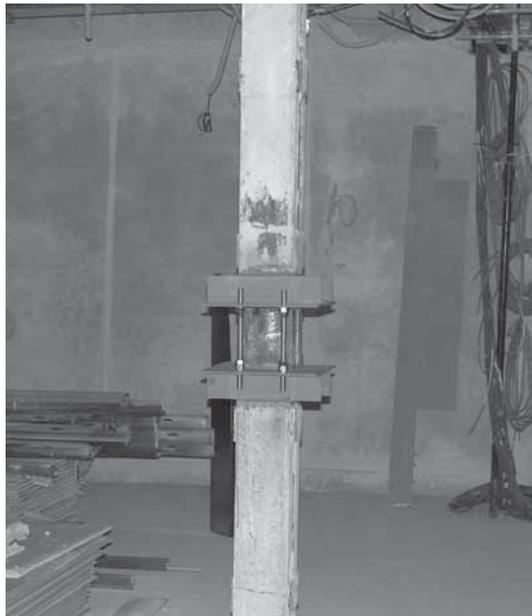
3. Ejecución de estructura auxiliar para la transmisión de las cargas a través del pilar durante el corte de es-
