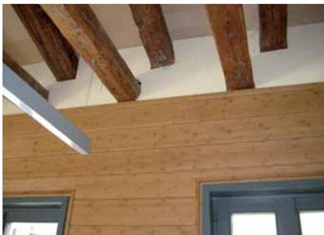
**El núcleo central de los 2 patios y escalera con forrado de madera de bambú machihembrada.**
