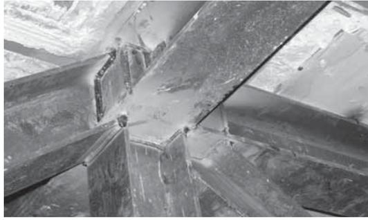
1. Ejecución de la cercha metálica. Vista de detalle de uno de los nudos de la cercha.
