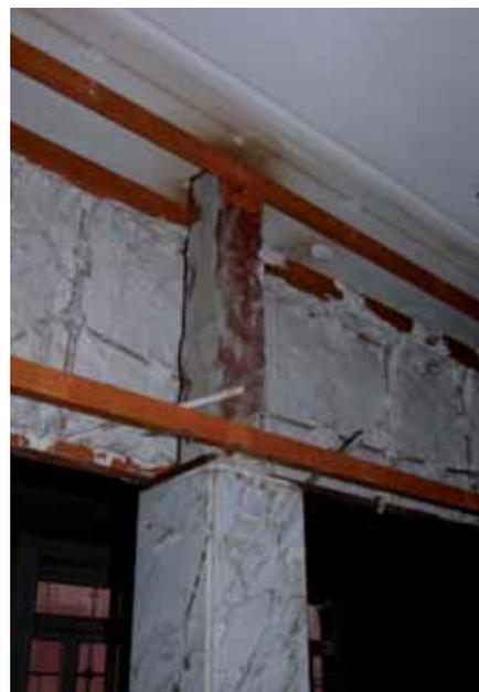
dificada) se realizaron en estructura de madera, de la misma calidad y esquadras que la existente. Al mismo tiempo, se sustituyeron los elementos que se encontraban en mal estado o no aptos para su función.
