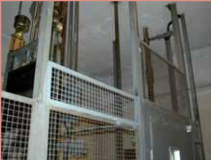
*Retirada del montacargas añadido en el hueco de la escalera posterior, a retirar para recuperar el estado original de la misma.*
