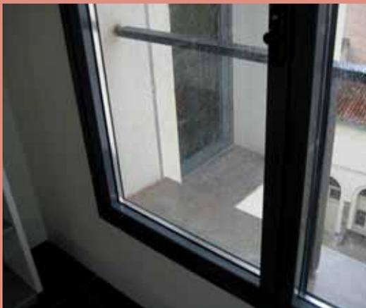
De aluminio, con rotura de puente térmico en patios 3, 4 y 6 y salida a la terraza del ático.
