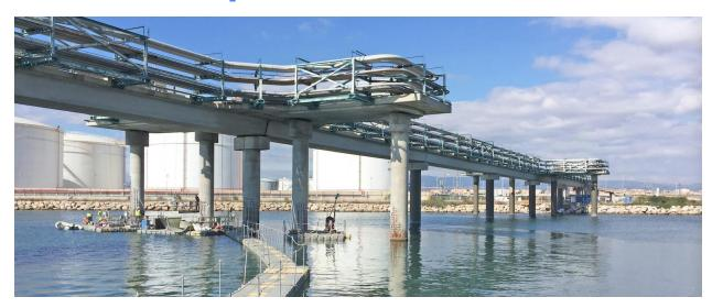
En esta referencia de la obra realizada "reparación de pilares de hormigón en el puente sobre el río Francolí en el Puerto de Tarragona" se puede seguir los pasos realizados y los productos utilizados para frenar los efectos de la corrosión, recuperar los pilares e impermeabilizarlos para protegerlos de la acción del mar y otros agentes agresivos.
