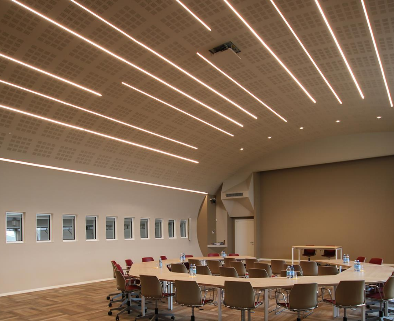
GYPTONE® BIG Curve Placas perforadas fonoabsorbentes
