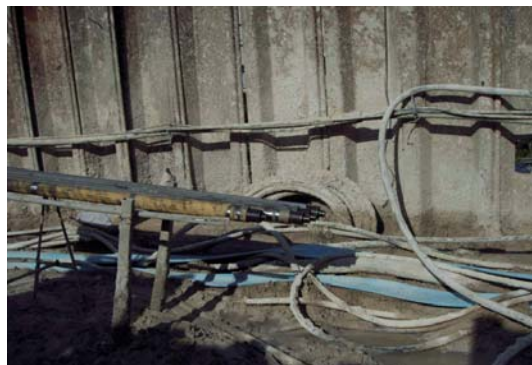
Ha de comprobarse el buen estado de las roscas y varillas. El empalme de las varillas debe ser firme.
